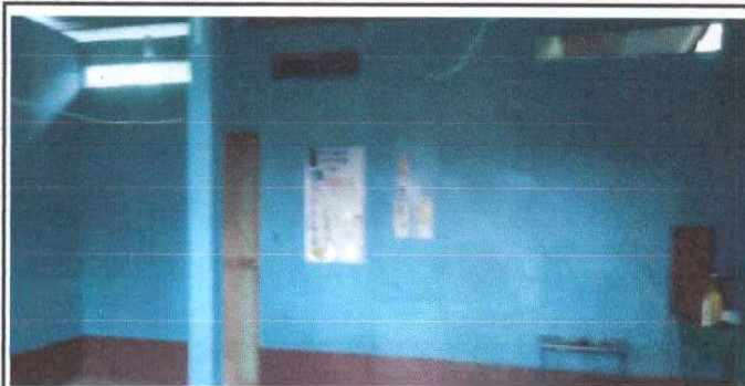
Foto7: Sustitución de pintura en muros de aula 1
