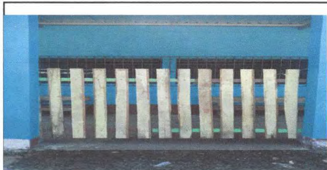
Foto 13: Sustitución de porton de metal aula 2
