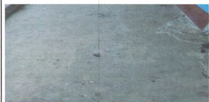
Foto 6: Sustrucción de piso ceramico aula2.
