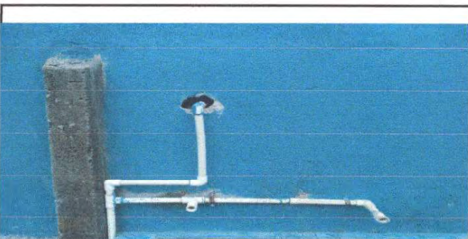
Foto 11: Sustitución de chorro en aula 2.
