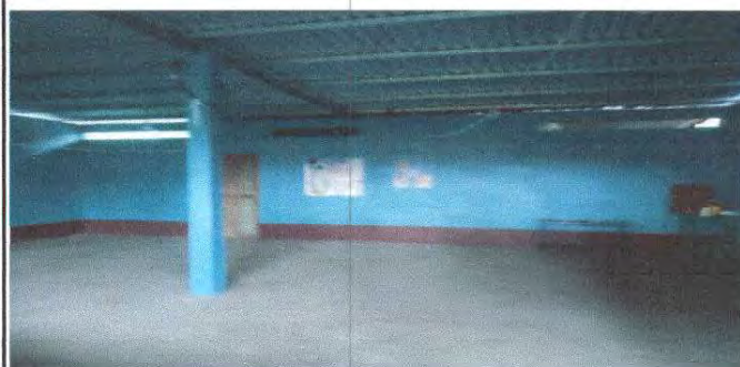
Foto 4: Sustrucción de piso Ceramico de aula 1.
