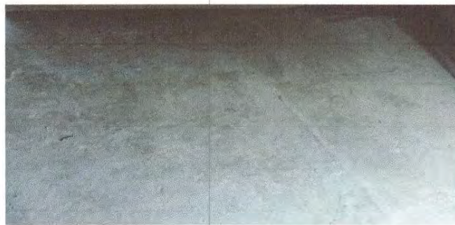
Foto 2: Sustrucción de piso de cemento liquido de bodega.
