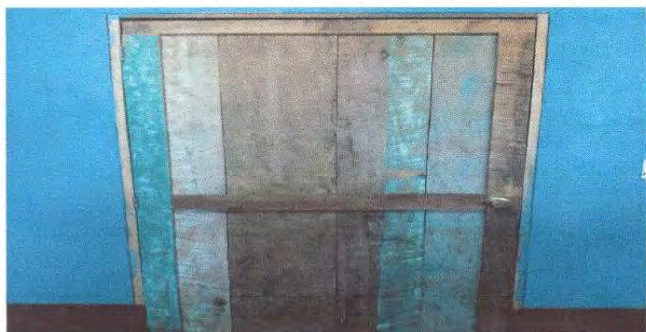
Foto 3: Sustrucción de puerta de metal de aula 1.
