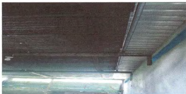
Foto 1: Sustrucción de lamina de bodega.
